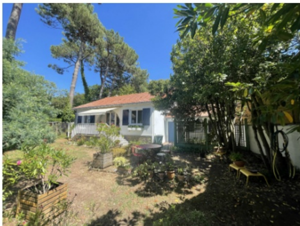
Vue sur la maison et son environnement très arboré. (Façade Nord-Ouest)
