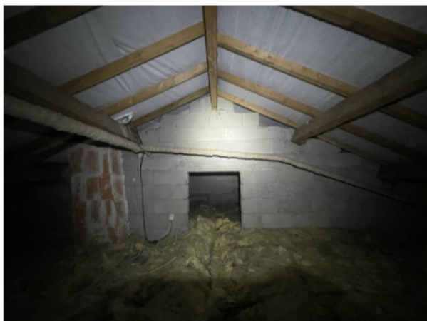
Vue sur la charpente en bois. Présence de la maçonnerie, du pare pluie et de l'isolation en laine de verre sur plancher.
