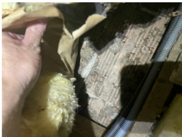
Vue depuis les combles sur le plancher bois.
