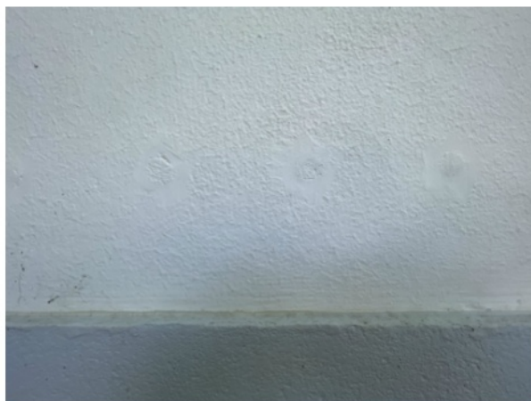
Vue sur la barrière d'étanchéité réalisée par injection dans le cadre du traitement des remontées capillaires du mur Nord-Est.
