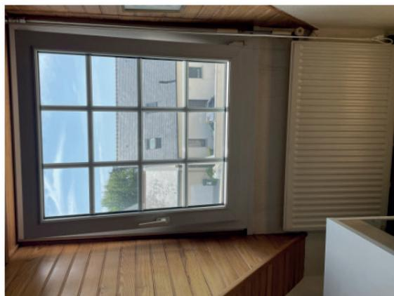
Menuiseries récentes en PVC double vitrage avec radiateur acier.
