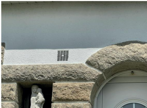
Grille de ventilation en partie haute des murs = déperditions thermiques.
