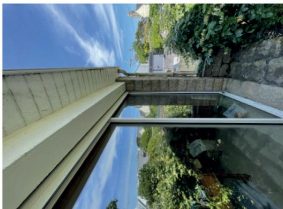
Baie vitrée côté jardin en aluminium double vitrage sans joint, ni rupteur de pont thermique
