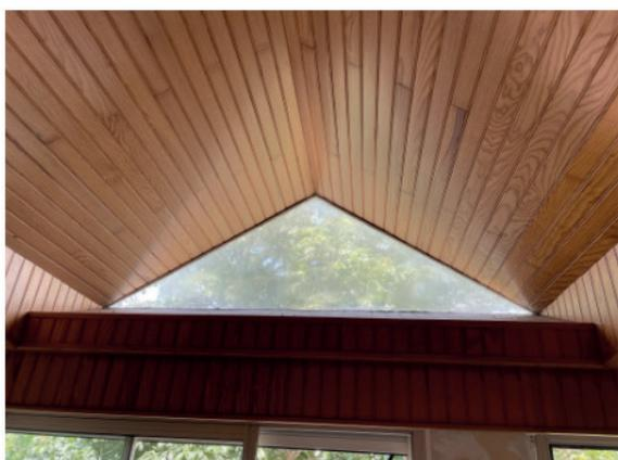
Fenêtre alu en simple vitrage (côté jardin) = déperditions thermiques
