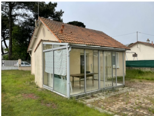
Vue extérieure sur véranda.
